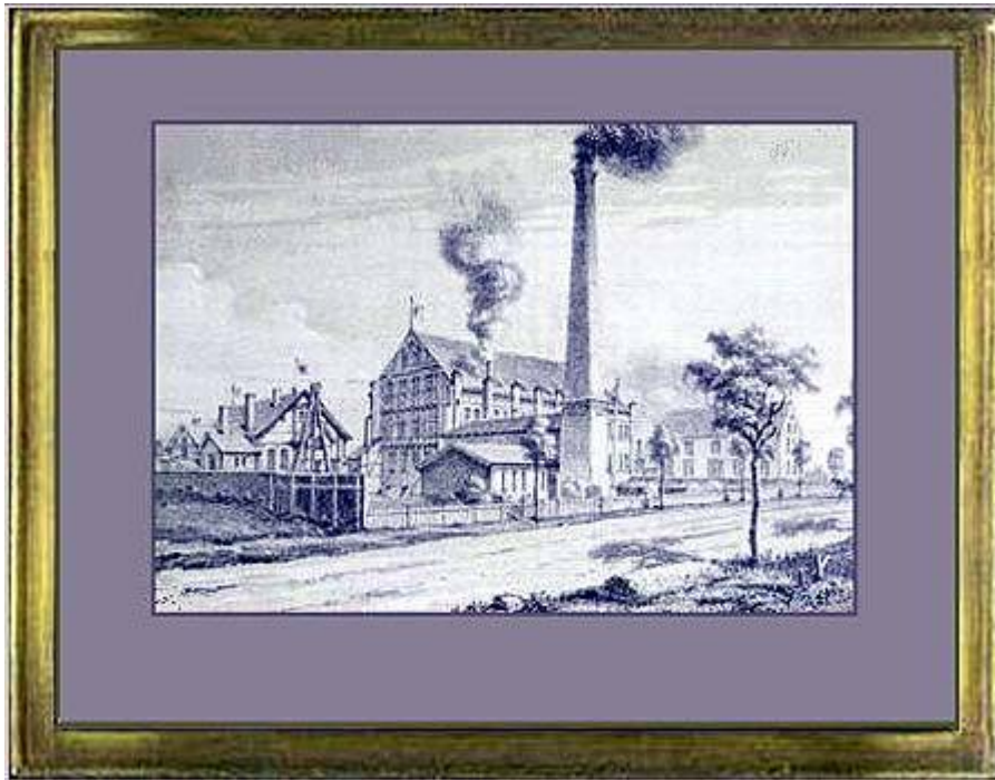
Królewska Przygotownia Elementów Stalowych.
