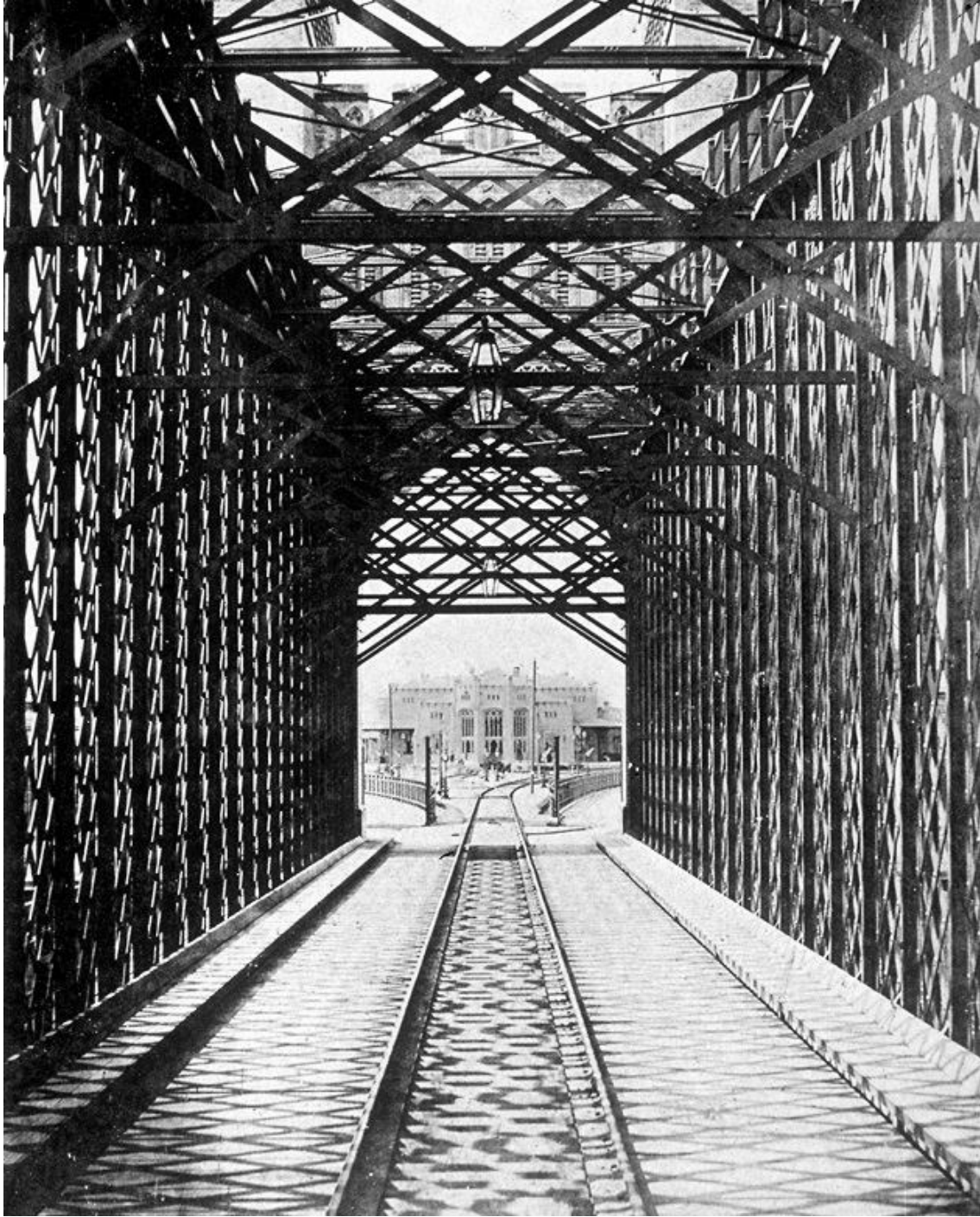
Widok z wnętrza mostu na gmach dworca w Tczewie. Zdjęcie pochodzi z 1857 roku. Zostało użyte przez profesora Wielanda Ramma z uniwersytetu w Kaiserslautern.
